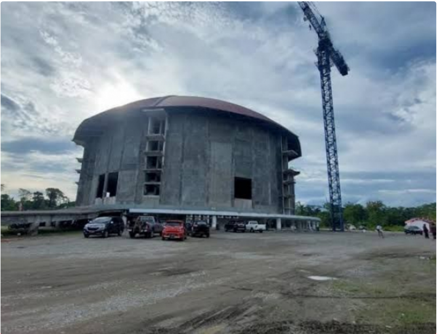
Pembangunan Gereja Kingmi Mile 32
